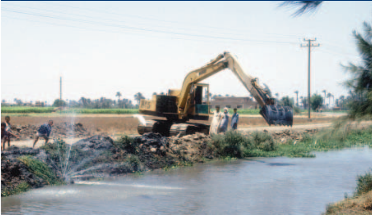
Lámina 13 Dragado de un canal de riego (Egipto)
