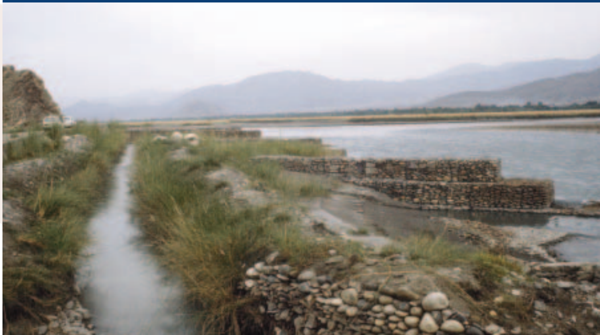
Lámina 2 Ingreso de agua a un canal y gabiones de protección de las orillas construidos por un programa de reparación de un esquema de riego (Afganistán)
