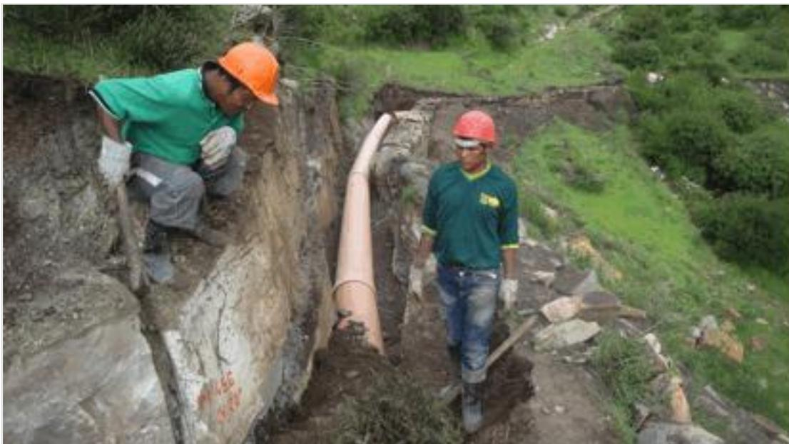
Fotos N° 16 - Muro de contención para proteger canal de conducción en la parte alta de la localidad de Viñas
