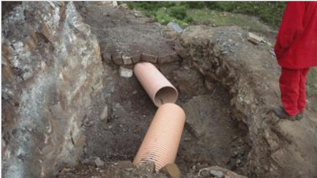
*Fotos N° 15 - Tapado del canal de conducción en el tramo Viñas-Pampahuasi-Pallpapampa*
