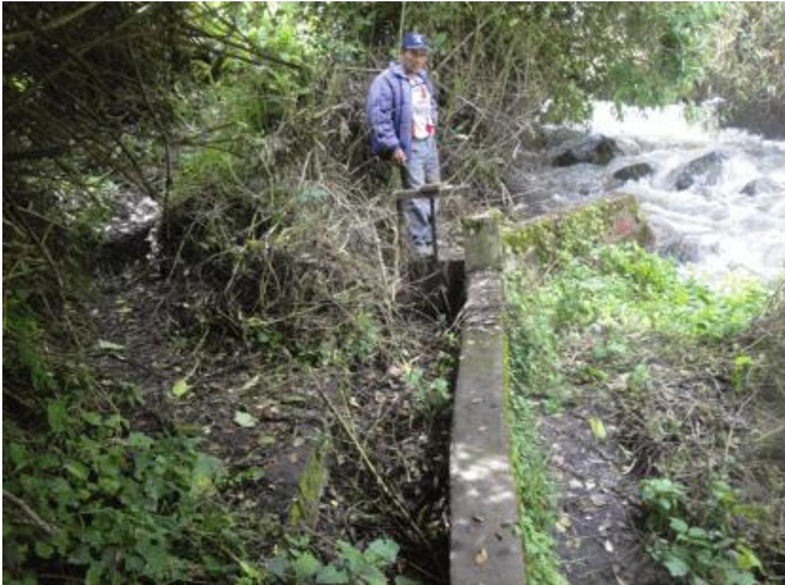
*Foto N° 18 - Infraestructura de la antigua Planta Hidroeléctrica, el lado derecho se usara para el canal de conducción del Proyecto de Irrigación*
